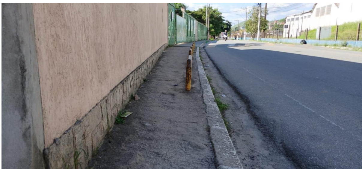
Figura 32. Estrutura das sarjetas na Av. Ver. Chequer Elias
