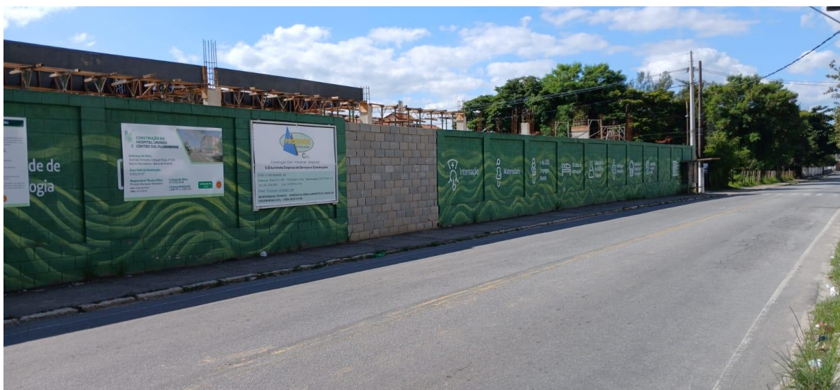
Figura 5. Vista Frontal do muro da Av. Chequer Elias
